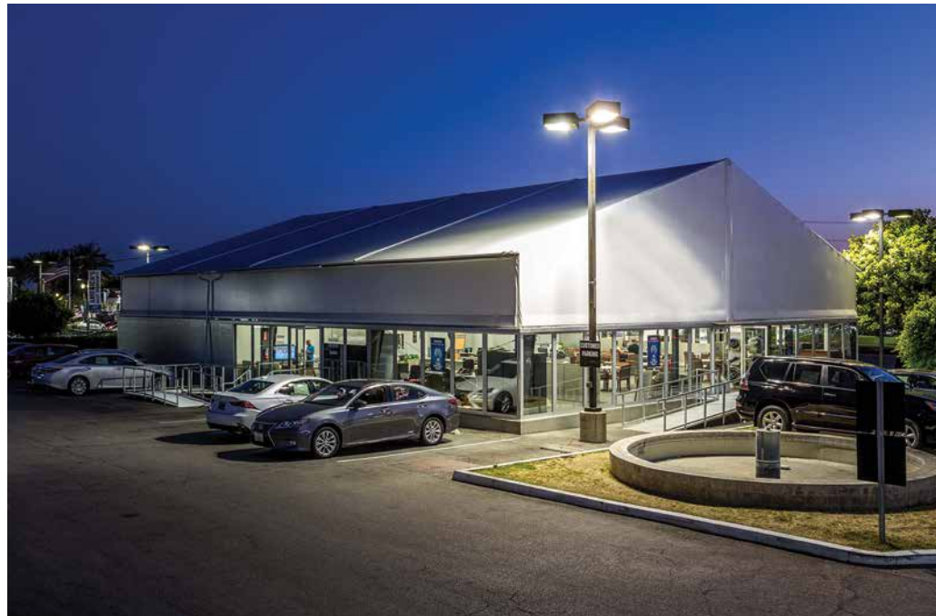
Figura 6 Concesionario de coches con paredes de vidrio: Diferentes revestimientos de pared están disponibles.
