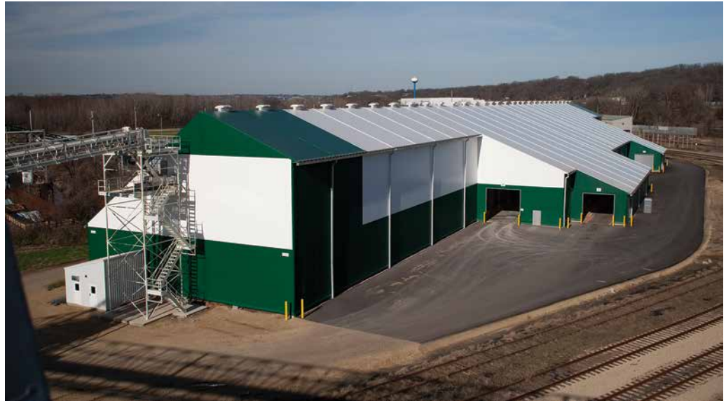
Figura 5 Operaciones de Fertilización Alliant Energy: Una estructura de almacenamiento de fertilizantes a granel para IEL Barge en Illinois. Los edificios de membrana tensada han sido utilizados como estructuras para el almacenamiento de granos, fertilizantes y materiales de mantenimiento de carreteras.
