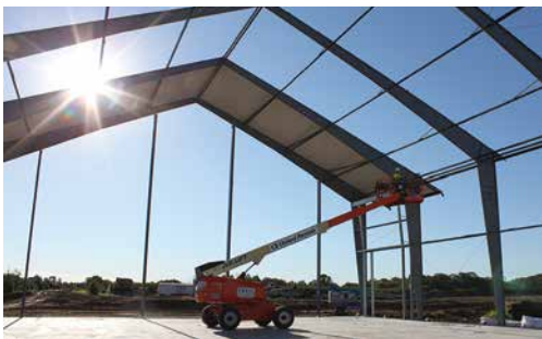
Figura 3 Estructura de Marco Rígido de Acero: Paneles de membrana tensada de techo siendo adosados a un edificio de marco rígido.
