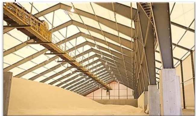
Figura IV: Vigas de acero sólido
