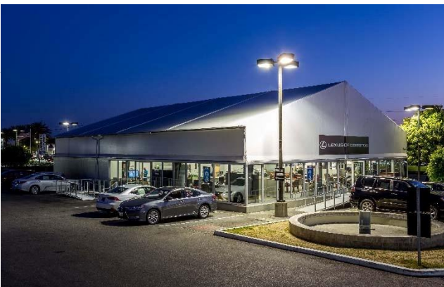
Figura XI: Edificio minorista hecho en tela, con pared vidriada
