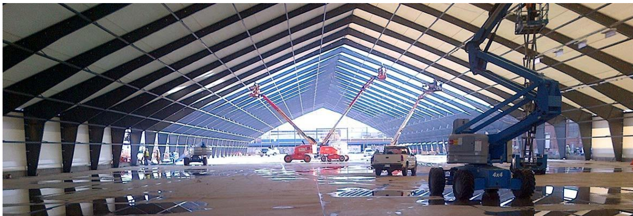
Figura VIII: Instalación de paneles de tela
