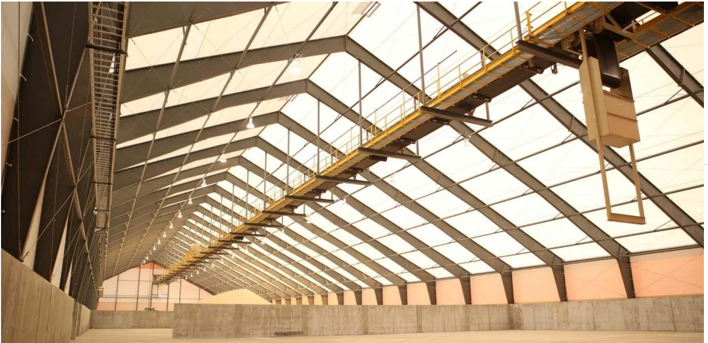
Figura VI: Interior deconstrucción en tela con armazón de viga-I de acero
