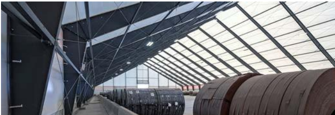
Figura IV: Armazón de placas sólidas de acero
