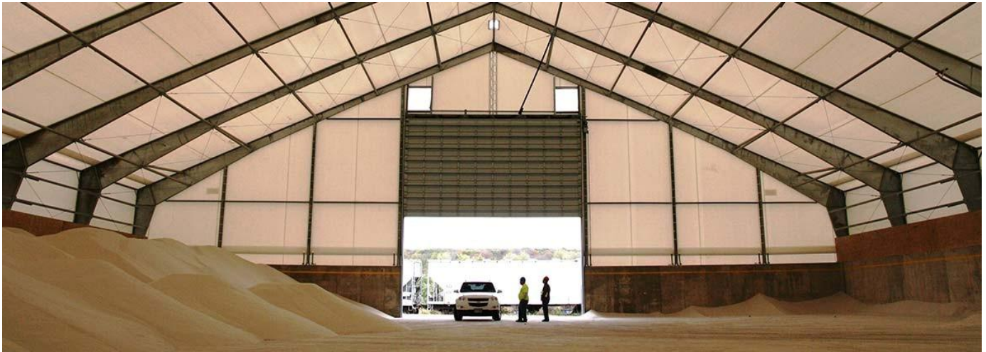
Figura VII: Buen diseño para almacenamiento de sal corrosiva
