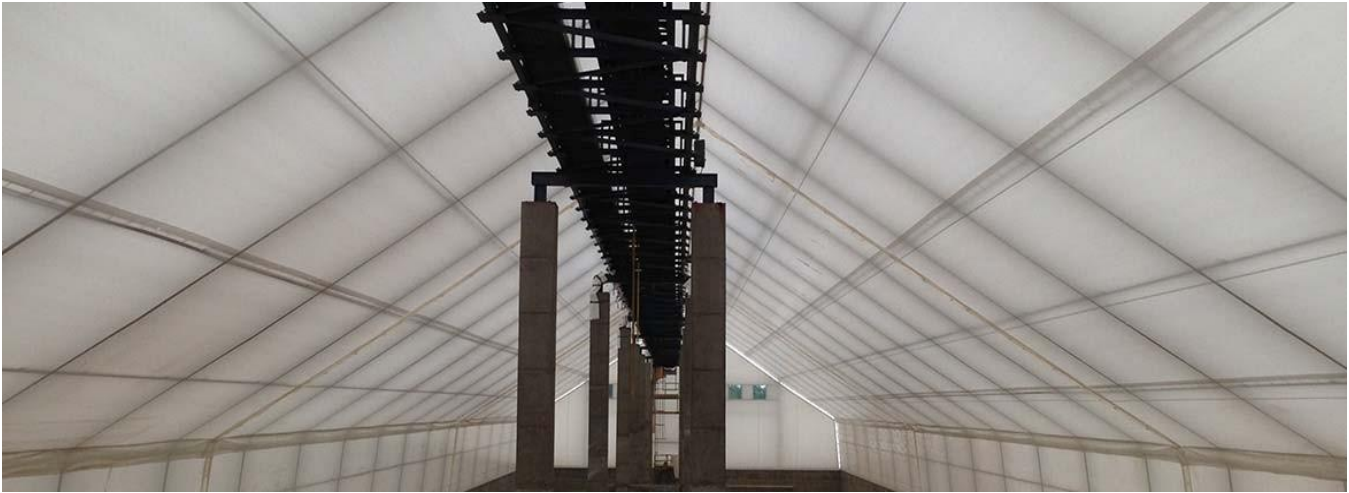
Figura II: Forro interior para proteger el armazón de acero
